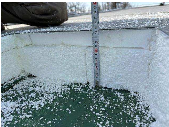
foto /3/ Zateplení horního pláště střechy
