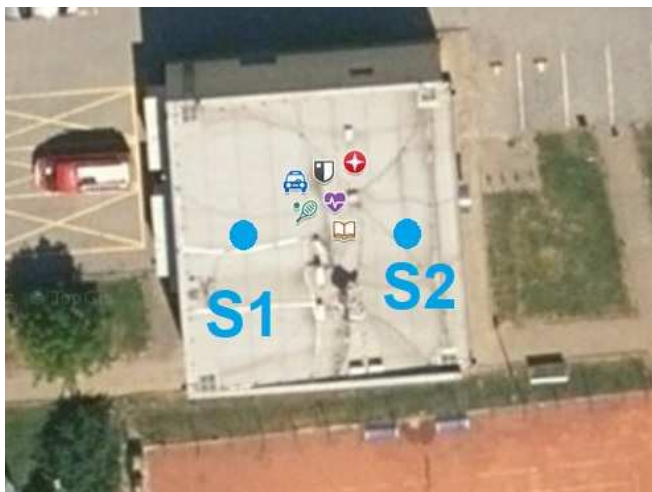
foto /2/ Střecha s vyznačením polohy sond
