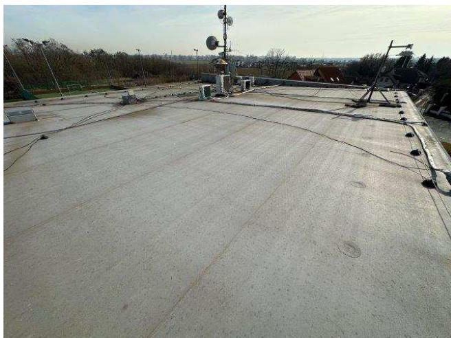
foto /1/ Pohled na střechu objektu
