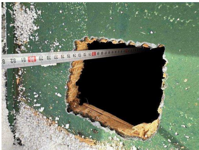
foto /4/ Vzduchová mezera mezi spodním a horním pláštěm střechy
