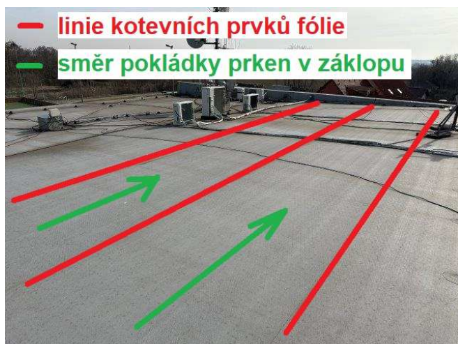
foto /9/ Kotvení fólie rovnoběžně s orientací prken v záklopu horního pláště střechy
