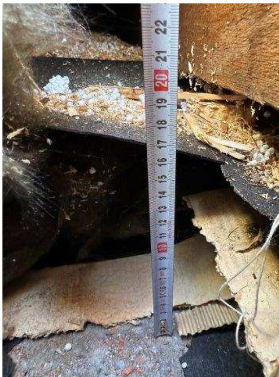
foto /6/ Tepelná izolace ze skelných vláken na spodním plášti střechy a nosná betonová konstrukce (pravděpodobně PZD desky)
